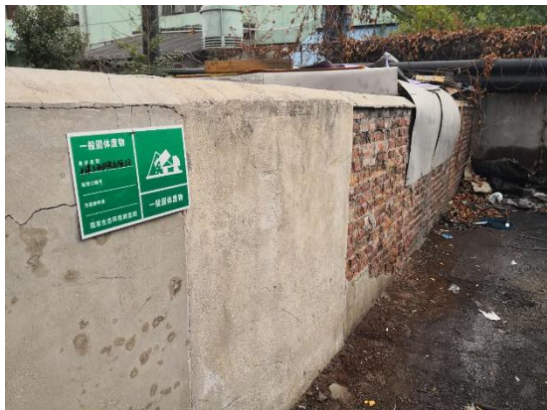
一般固废暂存处
