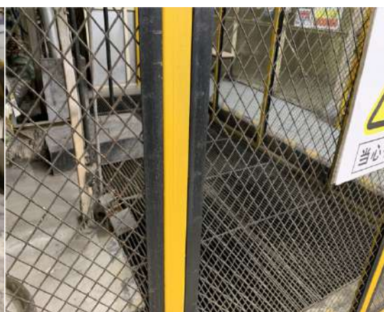
生产车间（电泳槽）地坑
