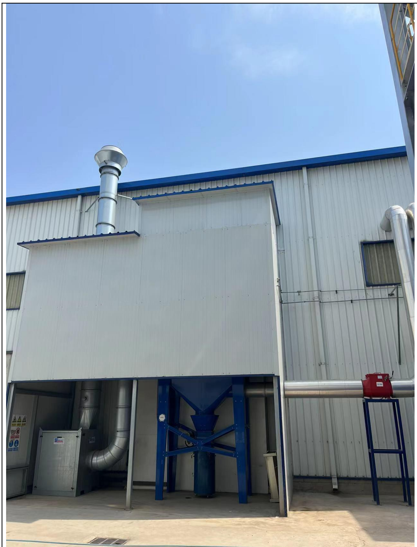
图 2-3 表面处理除尘设备示意图
