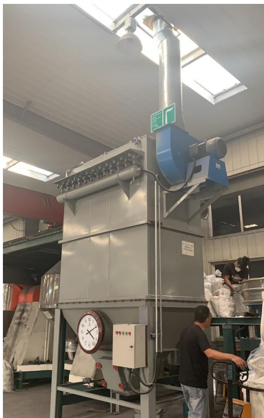
P2 排气筒及排污口规范化
