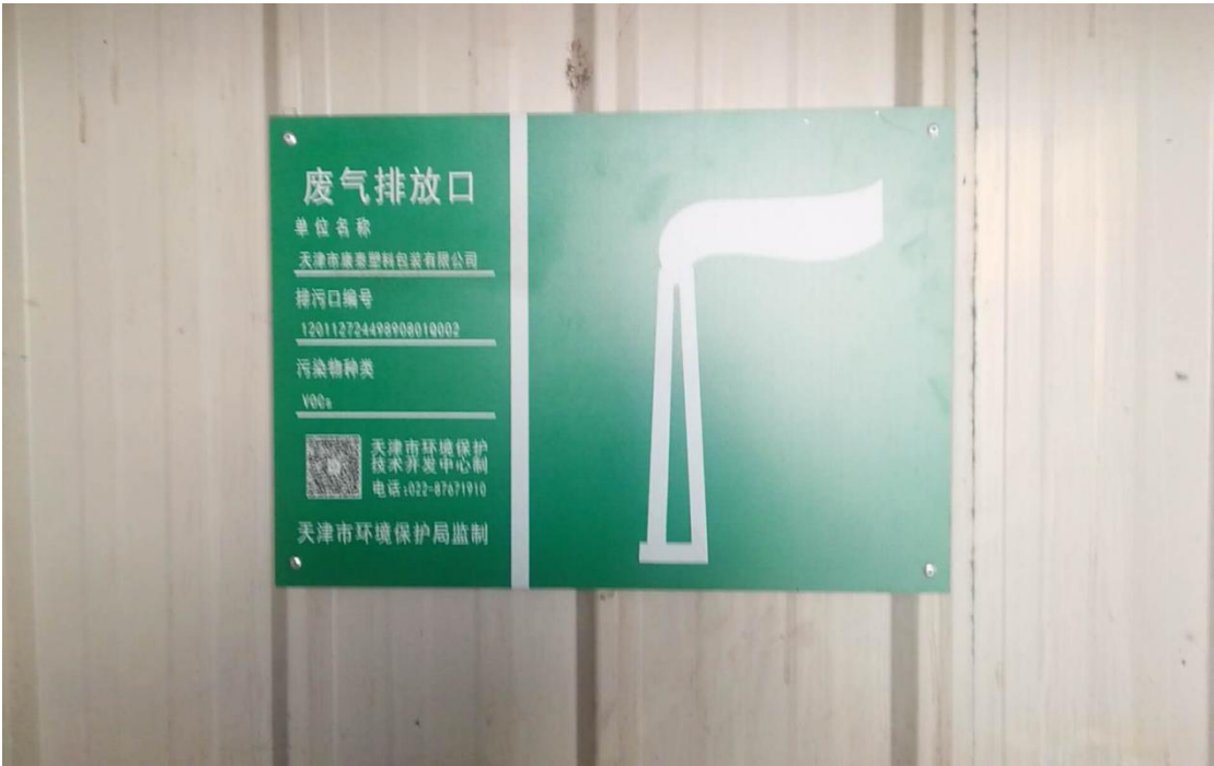
图 2 废气排放口环保标识牌
